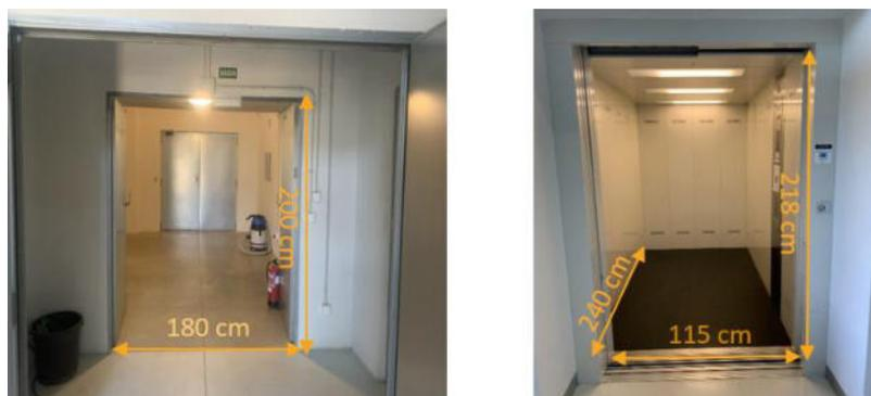
Figura 4. Acceso por el segundo sótano del edificio CITEXVI y ascensor.
